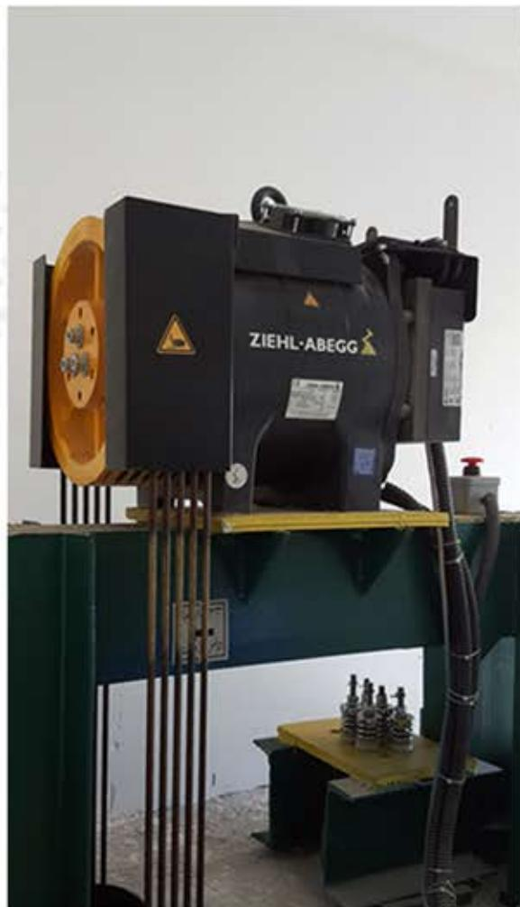
**سیستم محرک:** از نوع الکتروموتور بدون گیربکس (Gearless) مارک Ziehl Abegg آلمان، تیپ: درامی، دارای ۲۰ قطب مغناطیسی، مجهز به انکودر مارک Heiden Hain آلمان، مجهز به ترمز مارک Mayr آلمان با قابلیت جلوگیری از حرکت ناخواسته کابین به سمت بالا (UCM)
